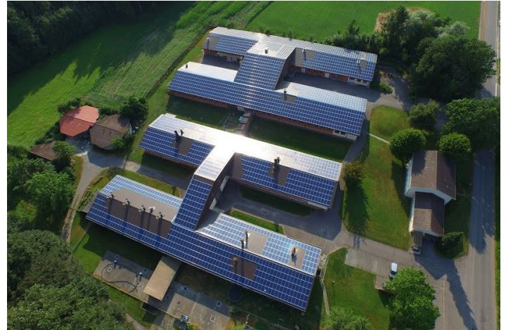
Abb. 1: Prüfstation MLP, Sempach
